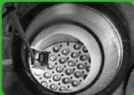
Przechowalnik wypalonego paliwa jądrowego – obiekt nr 19 w eksploatacji
